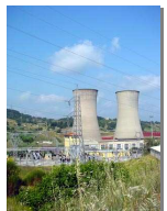
In Toscana, a Larderello, si trova uno dei primi impianti geotermici al mondo (1913).
